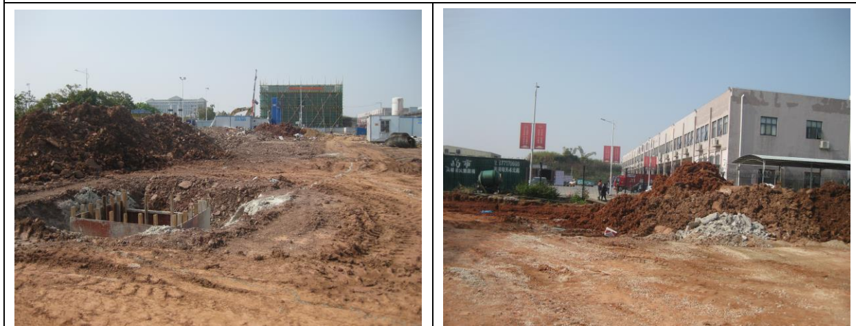
货运站表土临时堆放点
