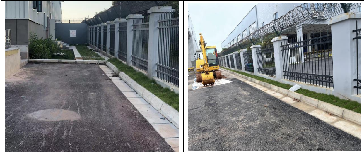
货运区场内绿化、排水措施
