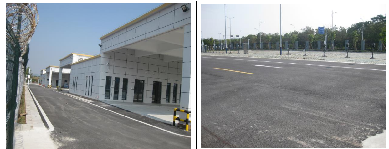
口岸查验场区场内道路硬化措施
