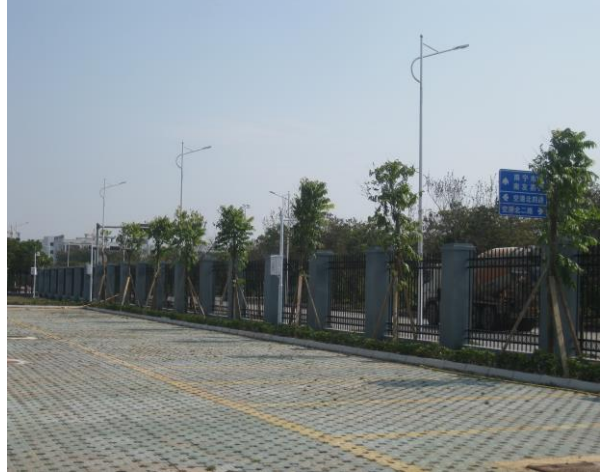
口岸查验场区内透水砖工程措施及植树绿化
