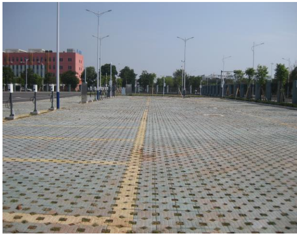
口岸查验场区内透水砖工程措施及植树绿化
