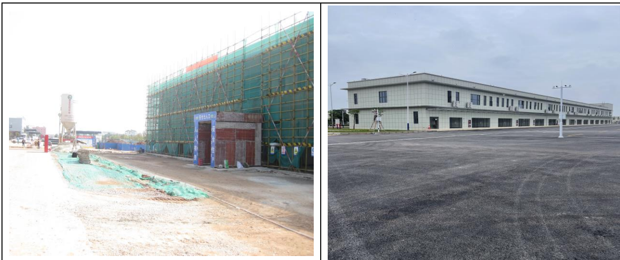
货运区场内地面硬化完成前后对比
