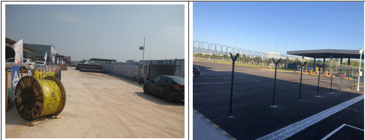
口岸查验场区内硬化措施完成前后对比
