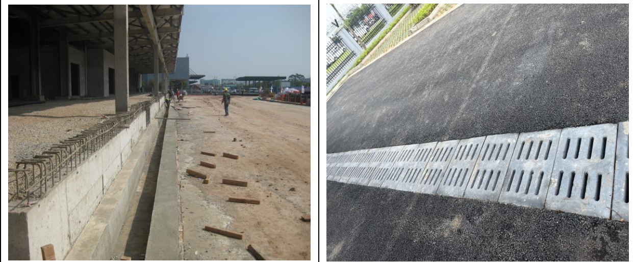
货运区场内排水措施
