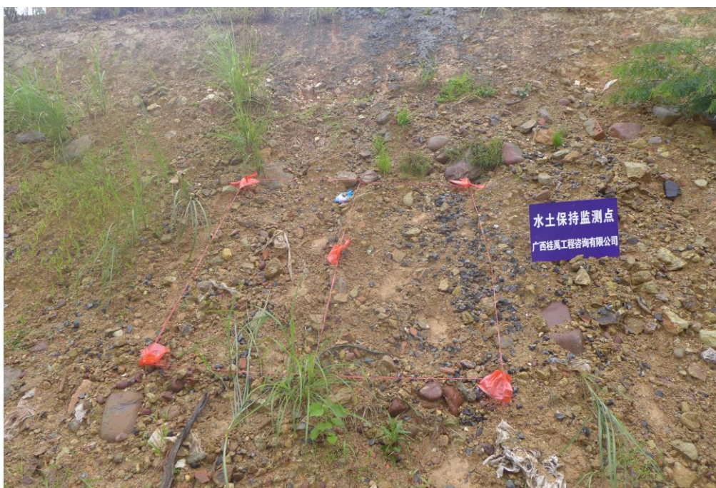
弃渣场边坡监测点（2021.11）
